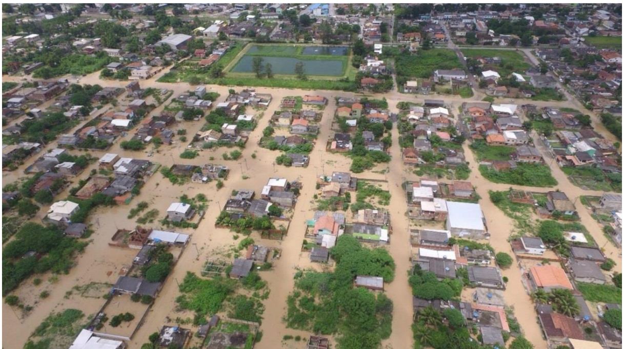
Figura 3. Inundação em Silva Jardim. Fonte: CILSJ (2021).
