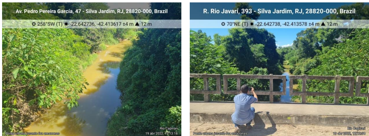
Figura 25. Ponte Foz do Amazonas, ponto visitado sobre o Rio Capivari, localizado a jusante da foz do rio Amazonas.
