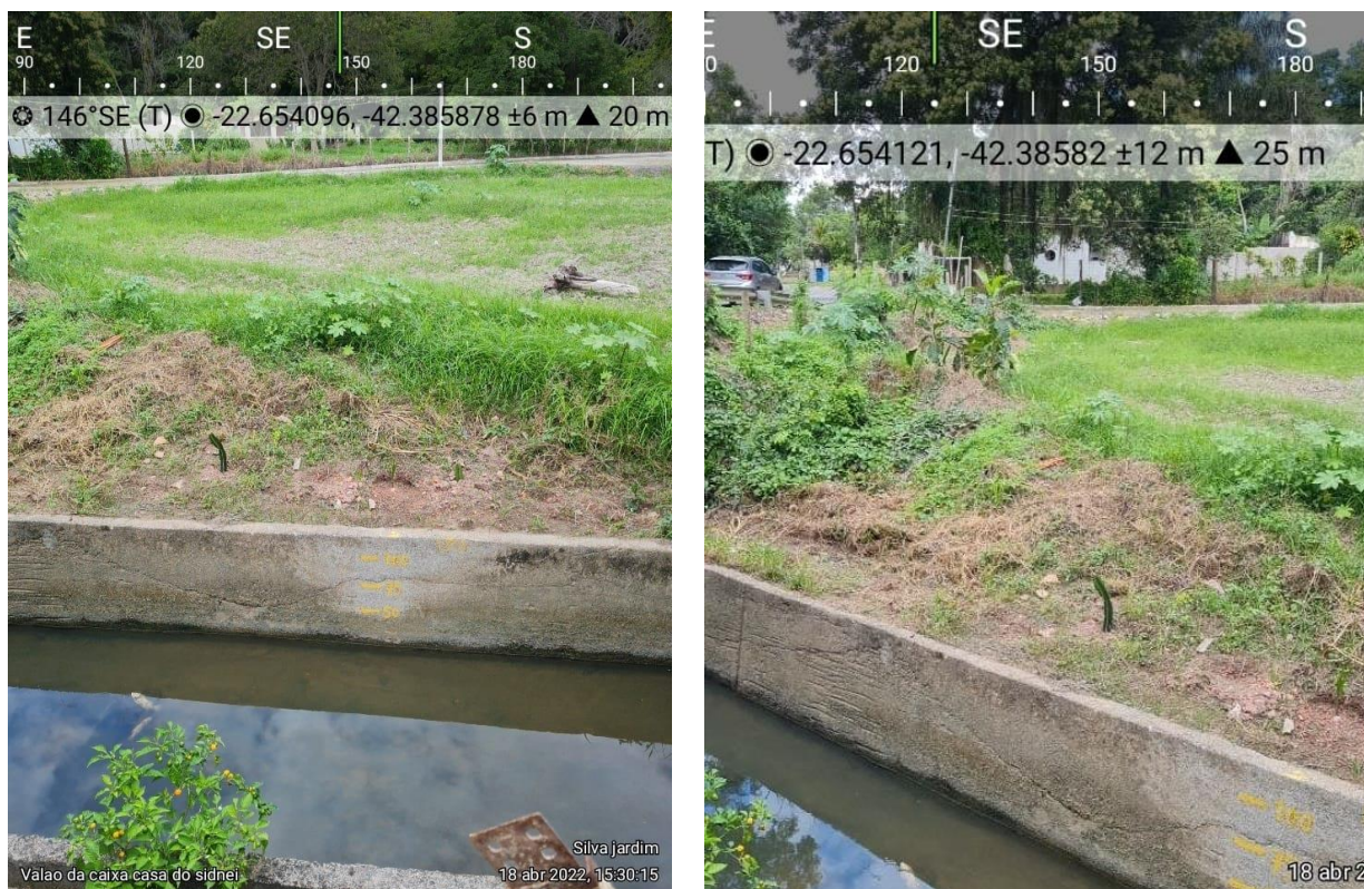
Figura 6. Valão da Caixa casa Sidnei, localizado justamente à montante da ponte da Av. Luis Gomes.
