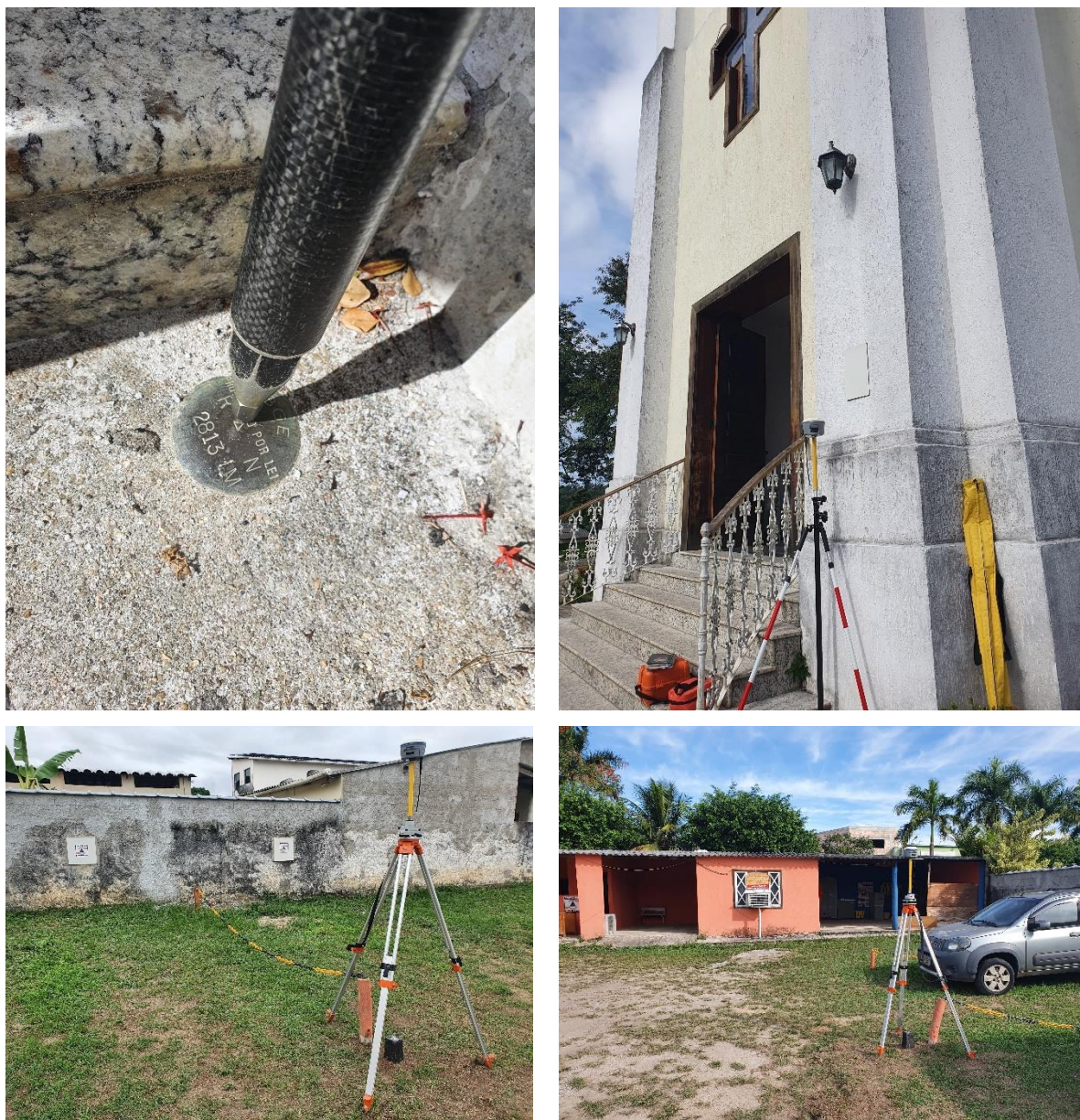
Figura 2. Marco geodésico do IBGE utilizado como referência de nível (linha acima) trasposto para o marco materializado na Defesa Civil de Silva Jardim (linha abaixo).
