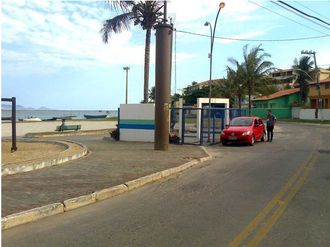
Foto 2 – Vista do local de interligação à Estação Elevatória (PV-009 – Baleia).
