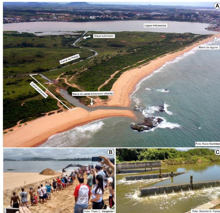
Figura 1: (A) Vista superior da Lagoa de Imboassica e as formas de ligação com o mar. (B) Episódio de abertura da barra da lagoa. (C) Vertedouro submerso construído para regular o nível de água da lagoa. Fonte: Farias (2018) 1
